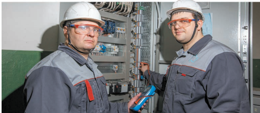
Руководитель группы эксплуатации АСУТП и телемеханики Алексей Уткин и инженер по контрольно-измерительным приборам и автоматике Алексей Топоров выполняют пусконаладочные работы на подстанции 6кВ в ходе внедрения проекта АСОДУ «Энергоснабжение»
