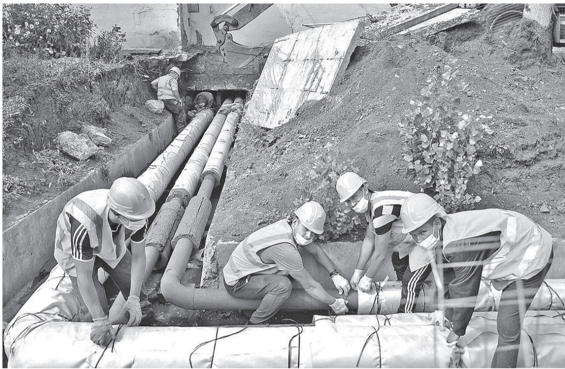
Реконструкция теплосетей и горячего водоснабжения на улице Лазарева, 4
